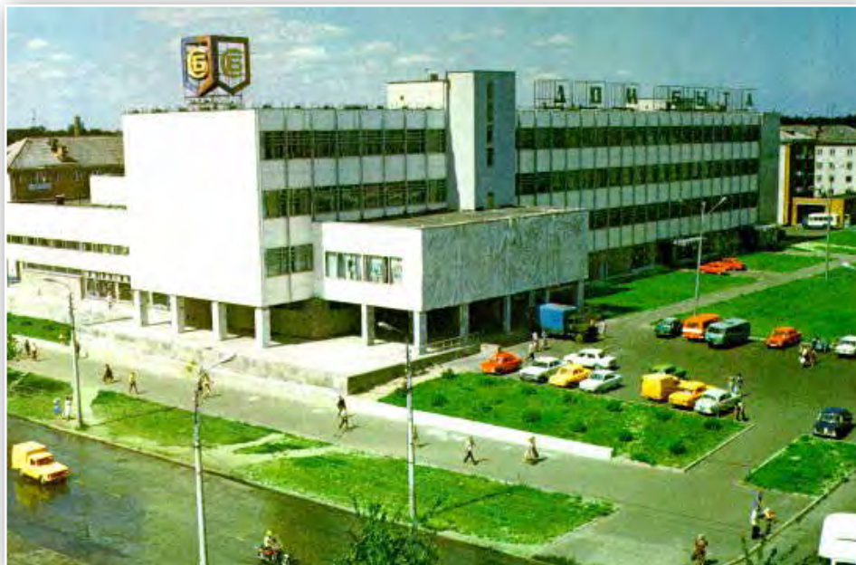
Здание центрального Дома быта. Арх. Б. И. Бердяев. 1979 г. (фото 1980-х гг.)
