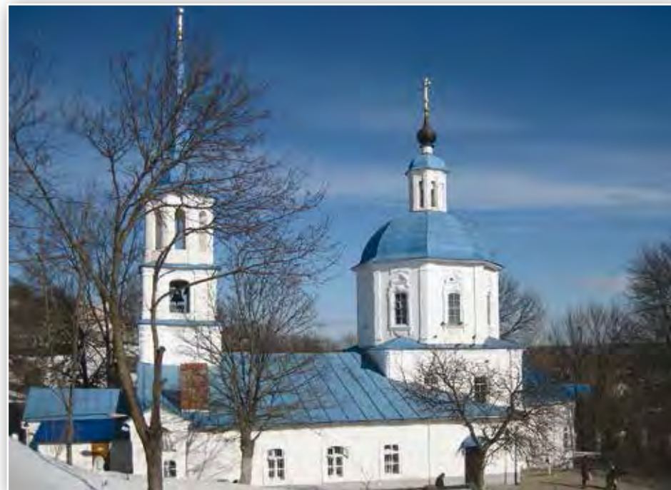
Тихвинская церковь. Реставрирована архитекторами Э.М. Кодисовой и В.Н. Городковым в 1980-х гг.
