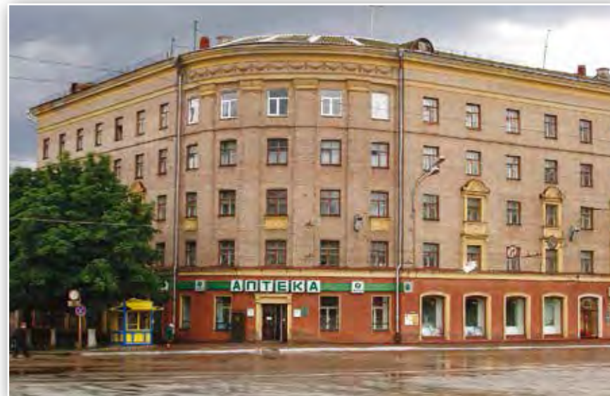
Архитектор В.Н. Городков. Жилой дом №24 по проспекту Ленина. 1957 г.
