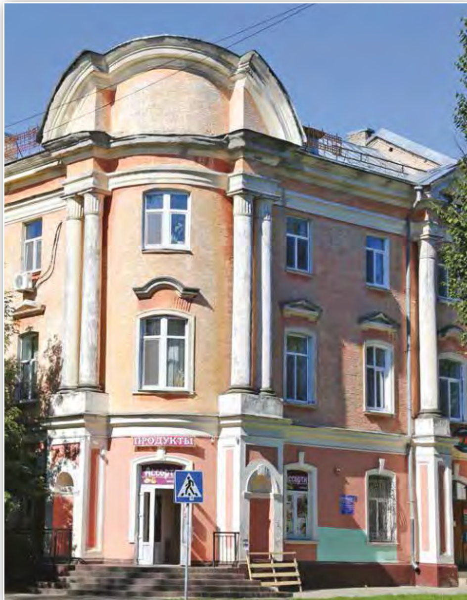
Жилой дом (ул. Комсомольская, 1) в стиле необарокко.
