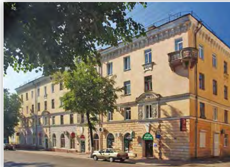
Архитектор В.Н. Городков. Жилой дом №37 по ул. Фокина. 1955 г.
