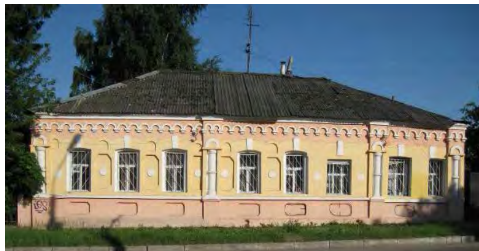
Жилой дом. ул. Урицкого, № 35.
