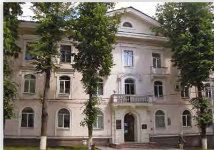
Архитекторы Н.В. Куспак и А.Е. Певцов. Административное здание по ул. Горького (1951)
