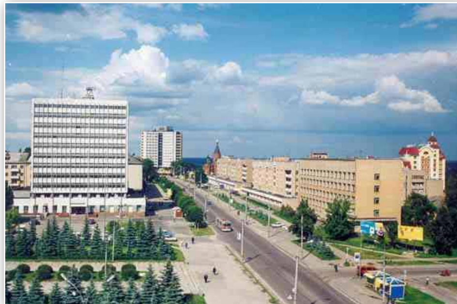
Здание проектного института «Брянскгражданпроект». Арх. Ю. И. Тарабрин. 1979 г. (фото 1990-х гг.)
