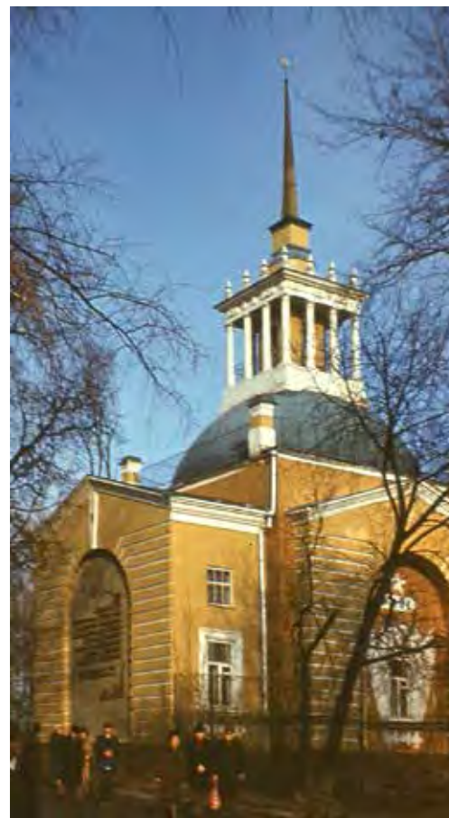
Здание спортзала после реконструкции. 1955 г. (Архитектор А.И. Певцов). Ныне восстановленная церковь Рождества Пресвятой Богородицы.
