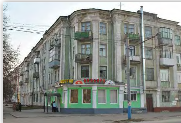
Жилой дом (Дом Стахановцев). Вид со стороны ул. 22 съезда КПСС
