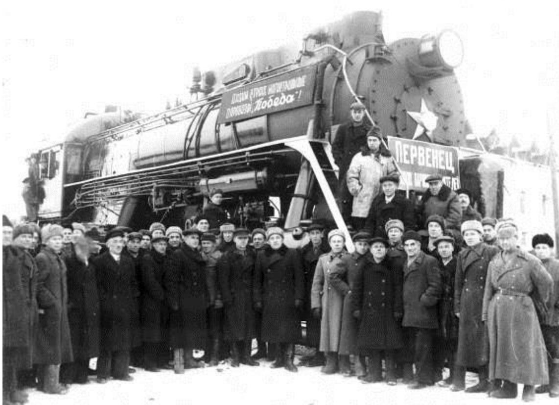
*Паровозы "Победа" ("Л") выпускались на БМЗ до 1950 года. Всего было построено 389 машин, которые эксплуатировались до середины 70-х годов. В 1949 г. был выпущен паровоз Лк с камерным пароперегревателем. Водоподогреватель БМЗ, созданный для паровозов "Л", был использован для модернизированного паровоза "ЛВ", выпускавшегося в Луганске с 1953 по 1956г.*
