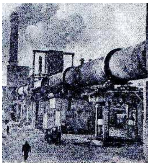
Новая печь на цементном заводе
