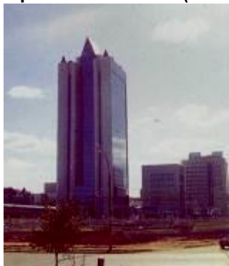
Центральное административное здание РАО «ГАЗПРОМ»(г. Москва)
