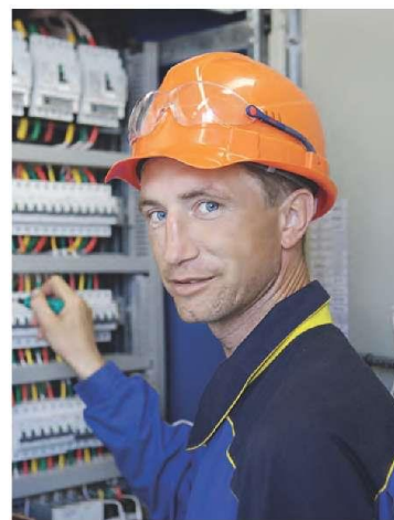
Инженер-наладчик ОАО «Уралмонтавтоматика» Владимир Кузьмин ведет наладку оборудования на НПС № 3
