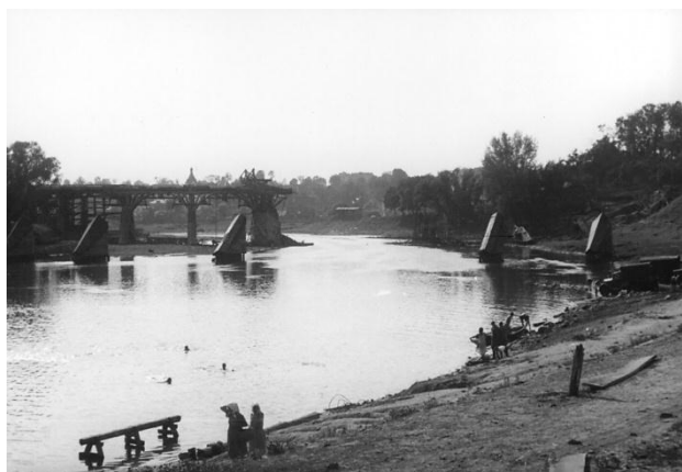
Мост через Днепр в Могилеве. Взорван в июле 1941 при обороне города
