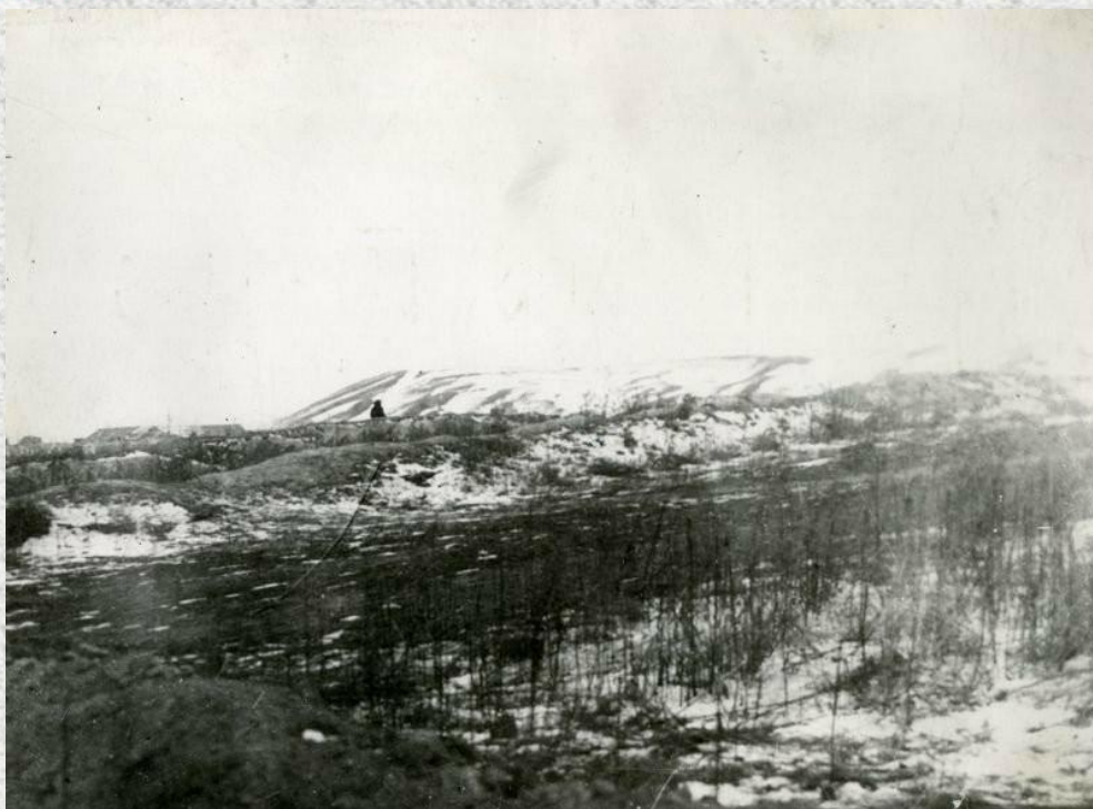
Так выглядела территория для строительства будущего завода. Красноярск, 1941 г. Из фондов КККМ
