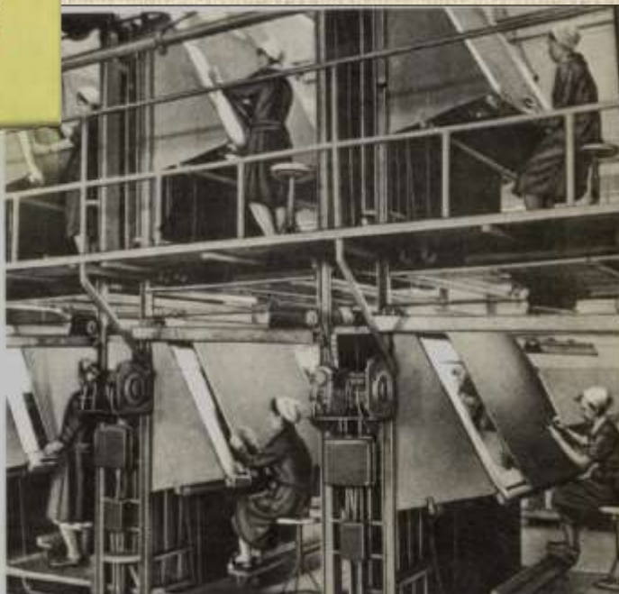
Рис. 41. Двухъярусная производственная линия очистки гребней в Брянском камвольном комбинате.
